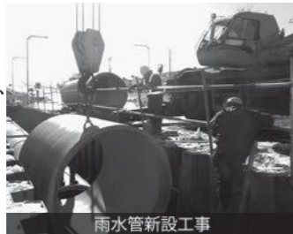
雨水管新設工事
